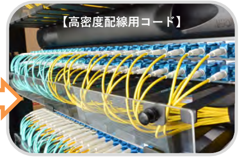
外径Φ2mmコードに光ファイバ素線が2本入っています
